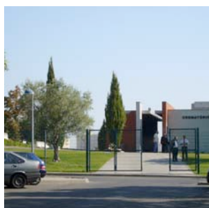
VISTA ENTRADA CREMATÓRIO
